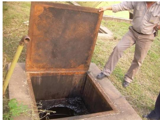
**Foto 7: Tanque subterráneo de aceite usado**
