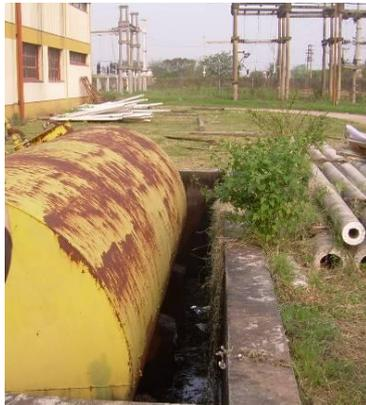
**Foto 6: Tanque de aceite sobre fosa de hormigón**
